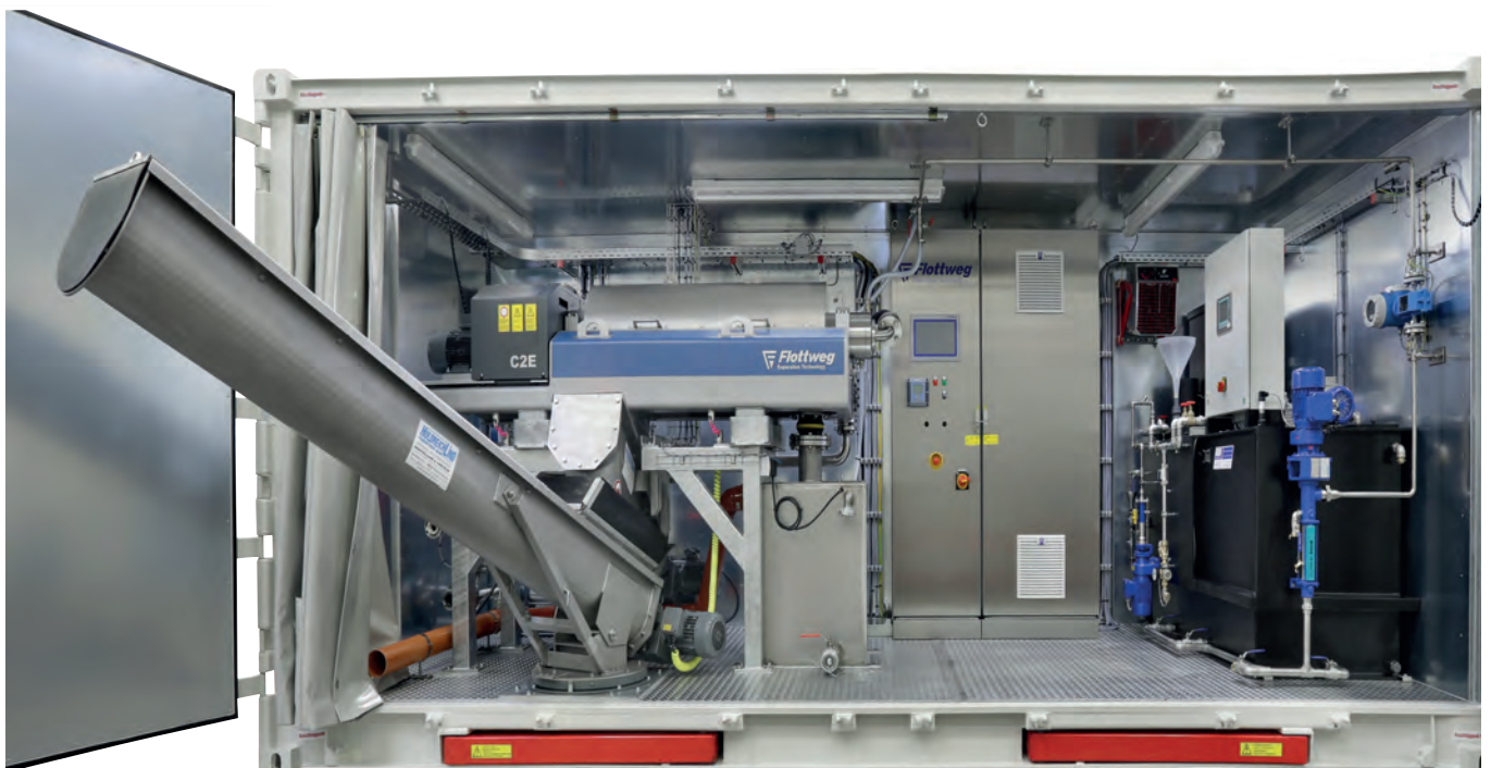
Dekanter Flottweg Z6E w niemieckiej oczyszczalni ścieków
